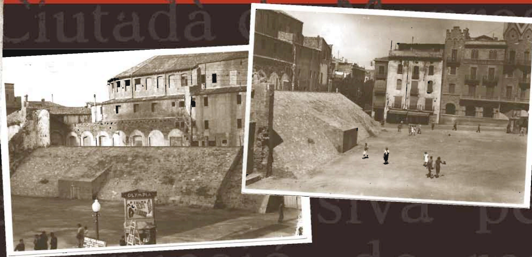
Refugi anti-aeri de la plaça de Sant Domènec. Començat a construir la tardor del 1937, el refugi va quedar anul·lat arran de la darrera reforma urbanística de la plaça. Font: Arxiu Comarcal del Bages. Fons Gamisans: fotografies de Llorenç Gamisans i Miquel Ausió.
